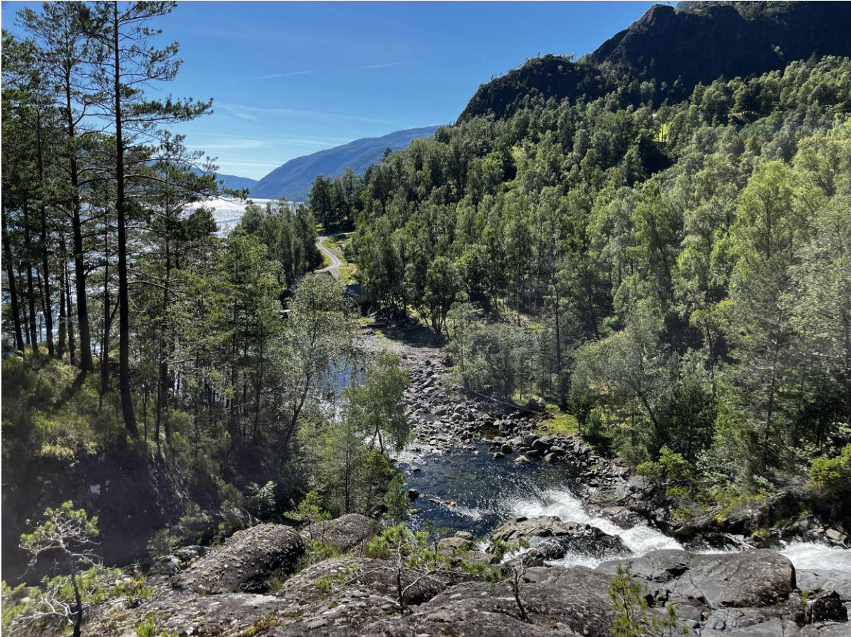
Figur 2.4. Kraftstasjonsområdet er planlagt i det tredekte området til høyre for veien på bildet.
